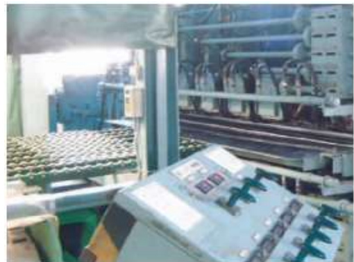
入側No1レベラー ワークロール上下計21本設置(φ 50mm)
